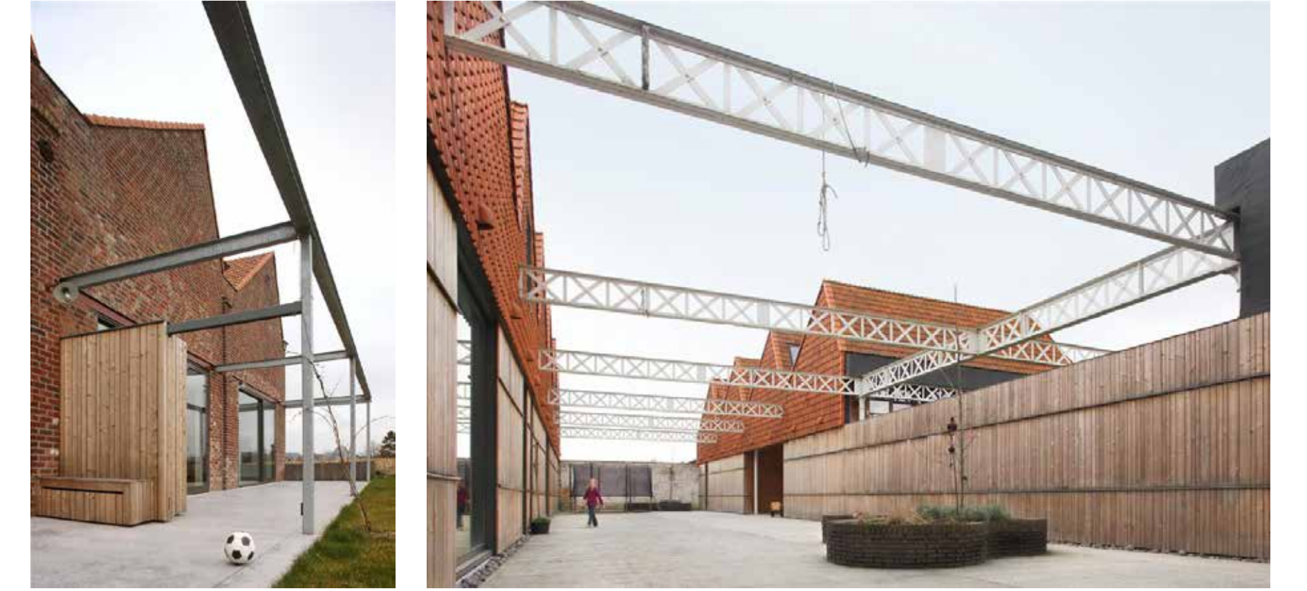
Verbouwing van een textiel fabriek tot een project voor 6 woningen, 1 atelier en 2 kantoorruimtes in Ronse, Volt architecten
